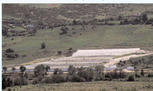
Hammam Bourguiba capacité : 230 m 3 /jour Treatment capacity:230 m 3 /day
