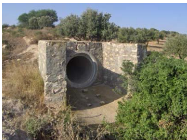
FIGURE 26 : CONDUITE DE SURVERSE EXISTANTE
