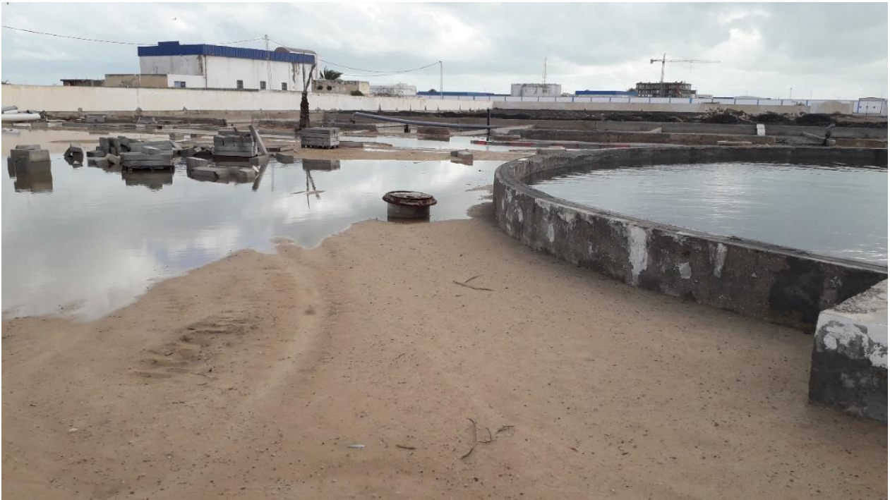
Figure 13 : Clarificateur noyé après évènement pluvieux
