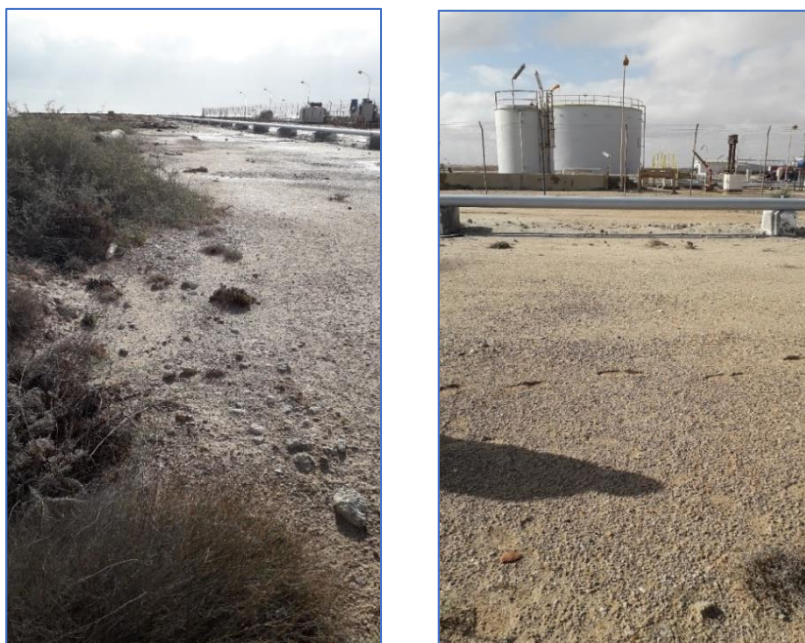
Figure 33 : Site de rejet des eaux usées de la STEP de Zarzis
