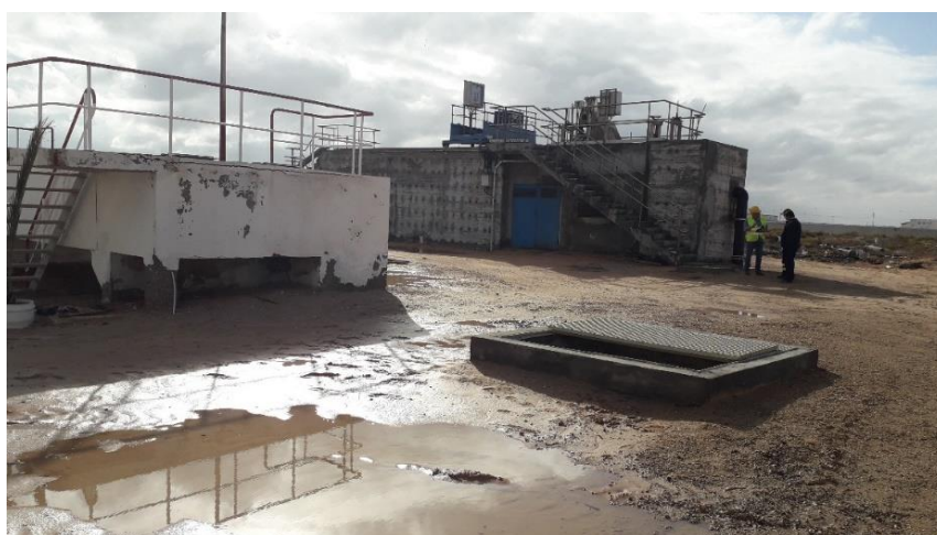
Figure 7 : Vue des deux ouvrages de prétraitement et de la chambre de vannes
