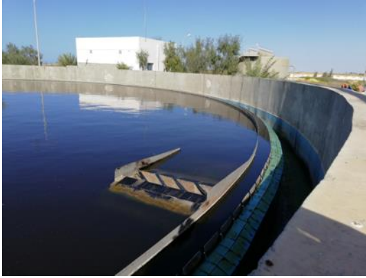
Figure 9 : Décanteur secondaire
