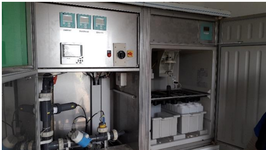
Figure 16 : Echantillonneur et poste de mesure qualité Eau Traitée
