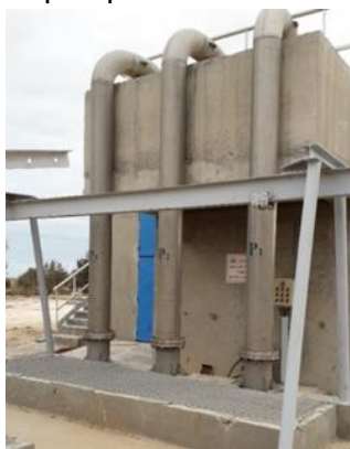
Figure 5 : Refoulement du pompage
