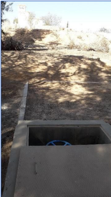
Figure 7 : Chambre de vanne sortie pompage EB, avec espace disponible pour création possible d'un regard
