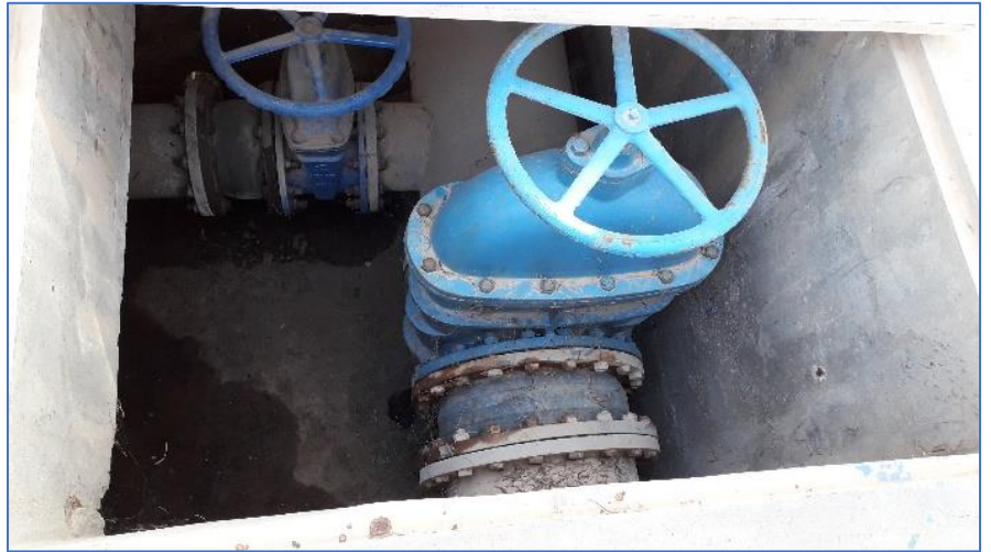
Figure 7 : Chambre de vanne sortie pompage EB, avec espace disponible pour création possible d'un regard
