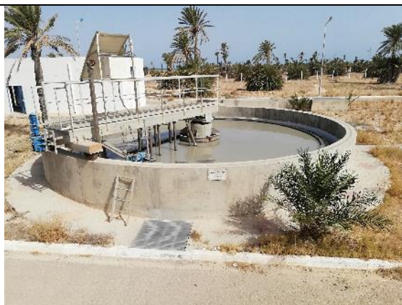
Décanteur secondaire
