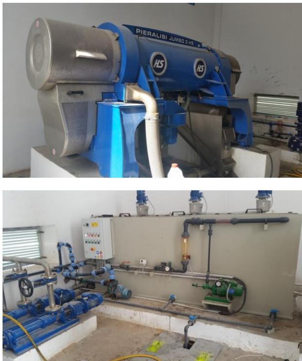
Figure 6 : Unité de déshydratation mécanique des boues
