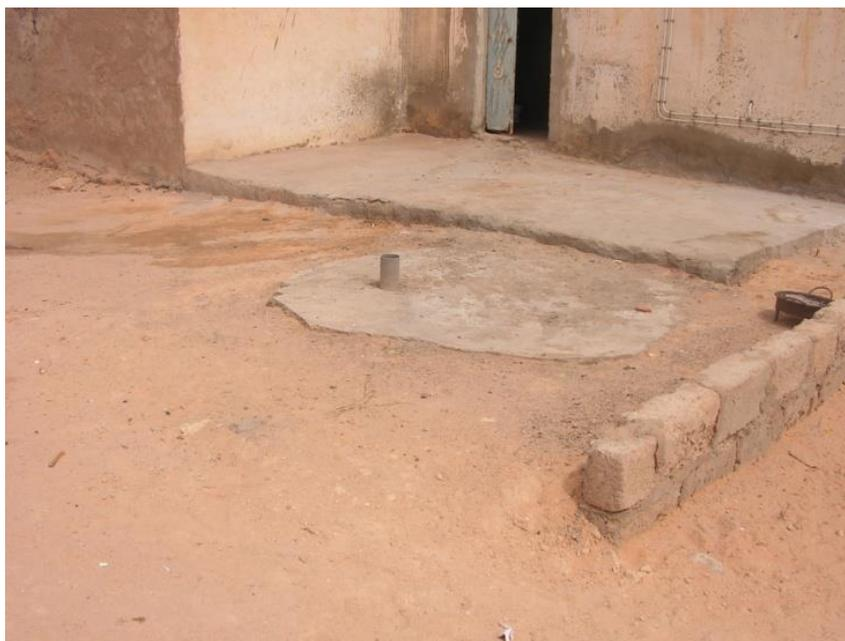
**Figure 15 : Assainissement par puits perdu**
