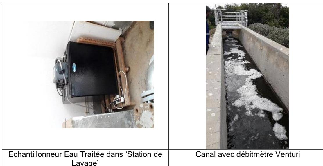
**Figure 10 : Instrumentation de la STEP de Jerba Aghir**
