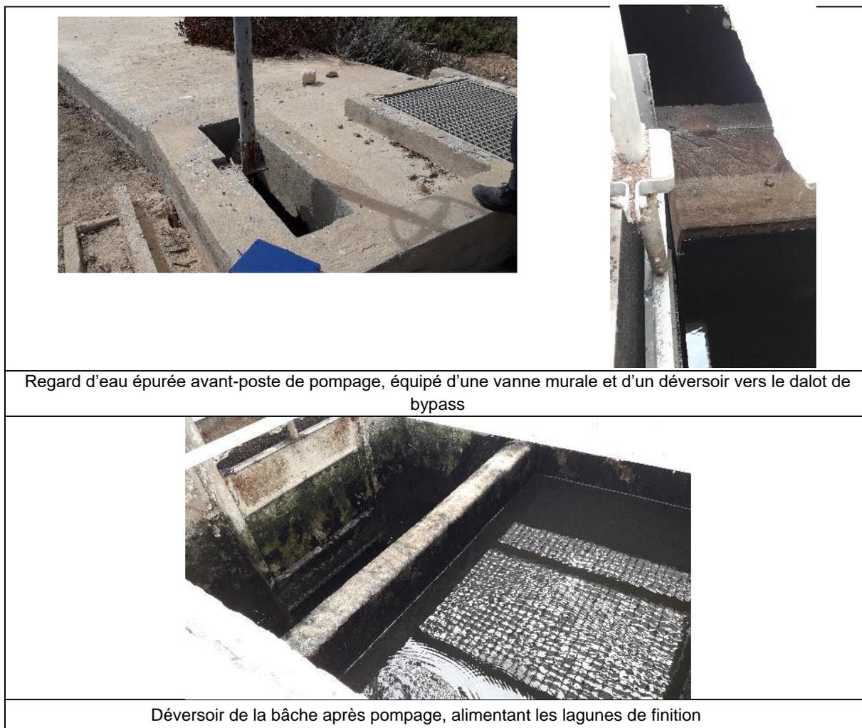
Regard d'eau épurée avant-poste de pompage, équipé d'une vanne murale et d'un déversoir vers le dalot de bypass
