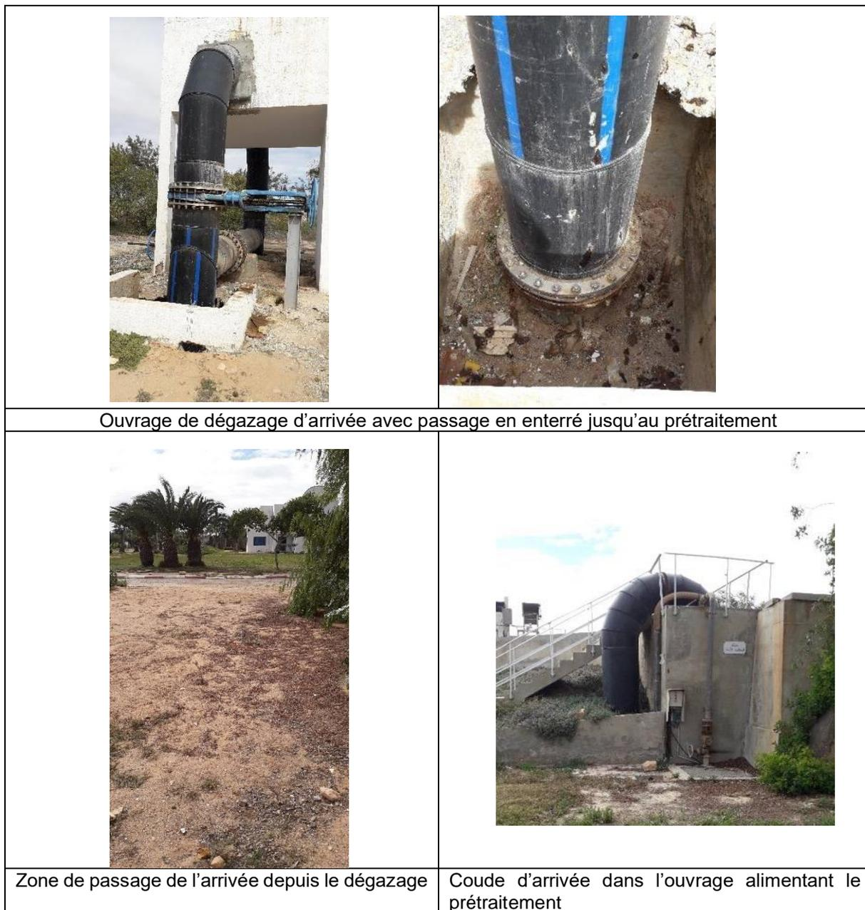
**Figure 5 : Ouvrages de dégazage de la STEP**
