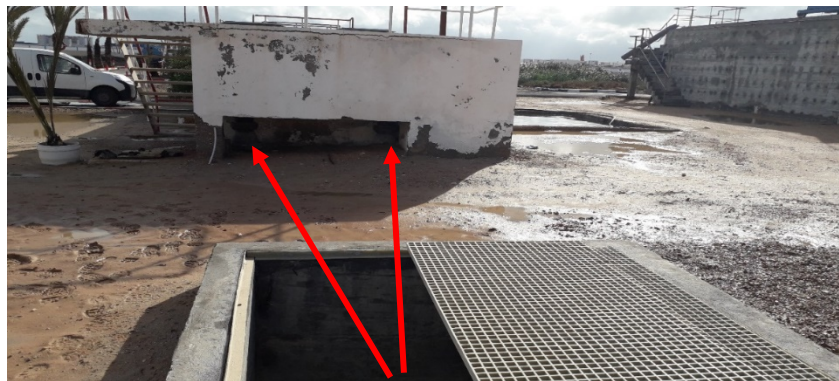
Alimentations de l'ancien prétraitement
