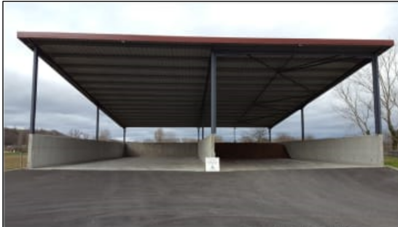
Figure 16 : Hangars de stockage de boues – Modèle type
