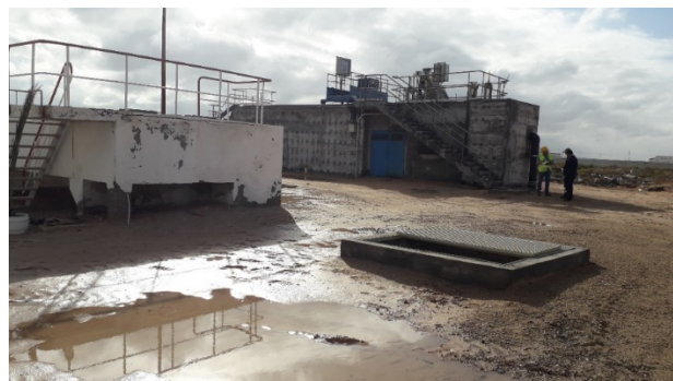
Vue des deux ouvrages de prétraitement et de la chambre de vannes
