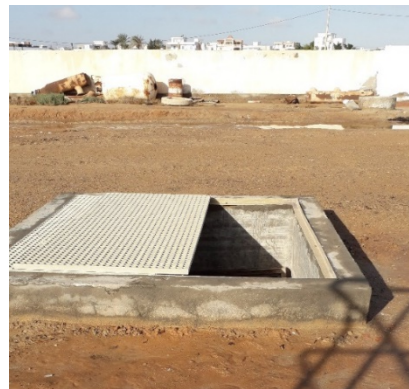
Vues de la chambre de vannes
