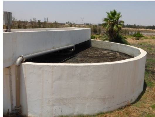
Figure 22. Herse d'un épaisseur (gauche). Epaisseur H/S (droite).
