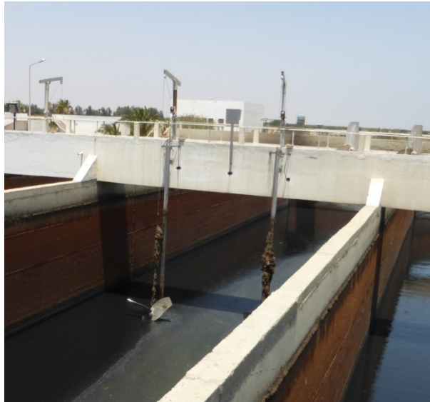
Figure 18. Vue des agitateurs dans le chenal
