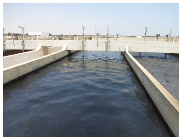
Figure 15. Vue de la zone aérée du chenal en fonctionnement et de la zone anoxie du chenal (droite)
