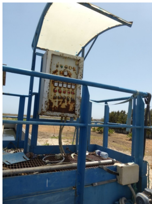
Figure 26. Groupe électrogène (gauche) et armoire électrique (droite).
