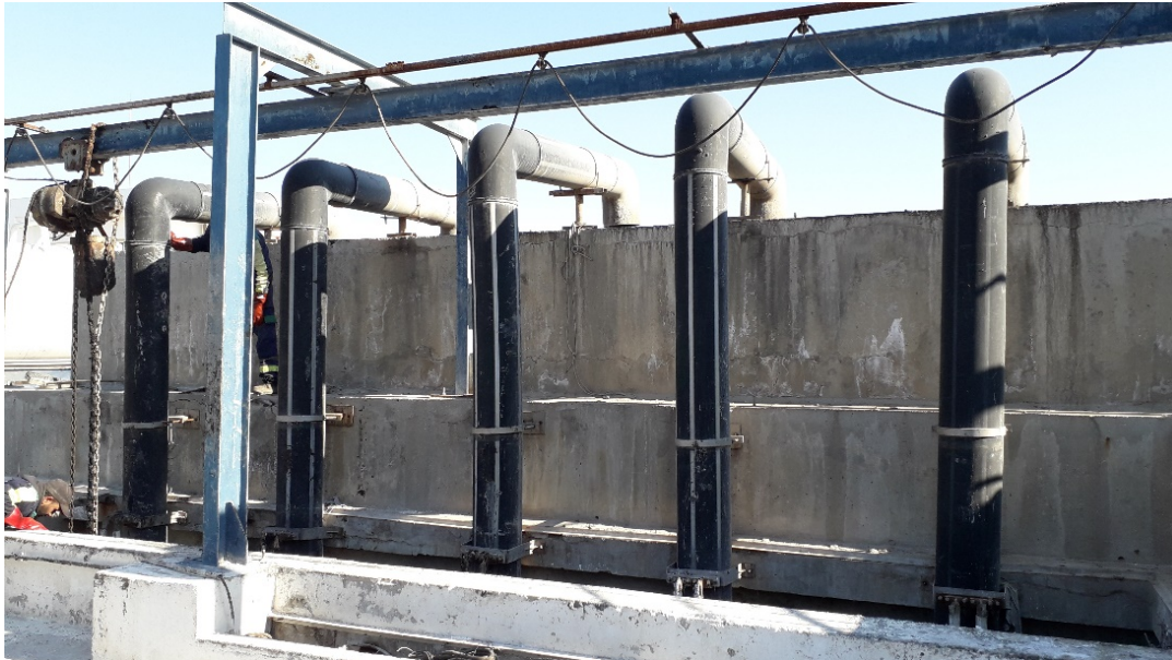
Figure 11 : Refoulement des eaux usées brutes
