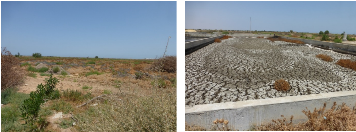
Figure 25. Zone de stockage de boues, sable et graisses (gauche). Boues chaulées sur le lit de séchage (droite).
