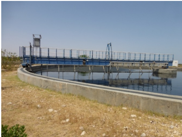
Figure 19. Vue des clarificateurs et de la présence de flottants, écumes et graisses en surface.
