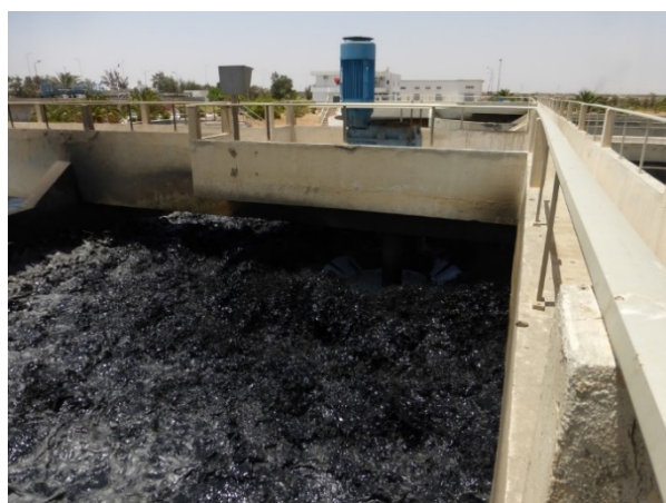
Figure 15. Vue de la zone aérée du chenal en fonctionnement et de la zone anoxie du chenal (droite)
