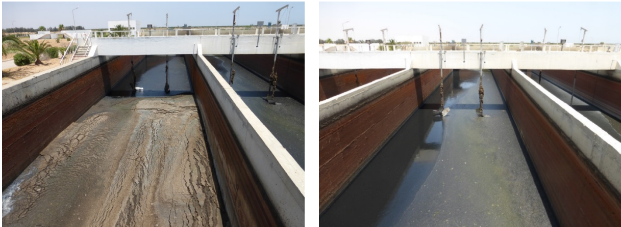
Figure 16. Vues du chenal vidé avec grande quantité de sable au fond du bassin
