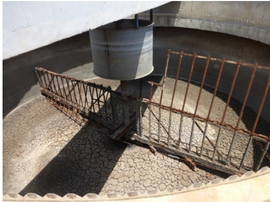
Figure 22. Herse d'un épaisseur (gauche). Epaisseur H/S (droite).
