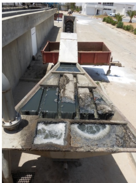
Figure 14 : Classificateur de sable
