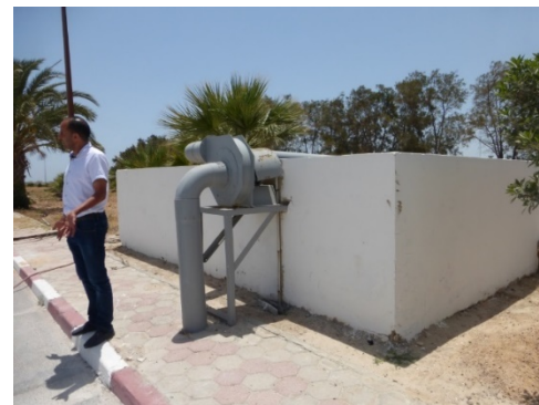
Figure 24. Vue de la surface du biofiltre (gauche) et du ventilateur (droite)
