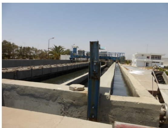
Figure 13 : Dessableurs/dégraisseurs
