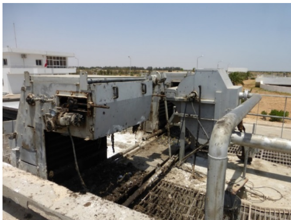
Figure 12 : Dégrilleurs et tamis rotatif (garuche)
