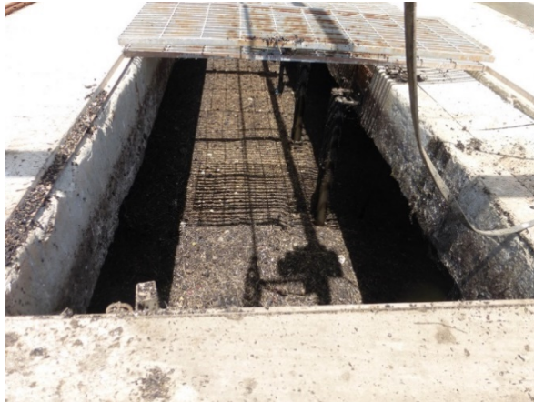
Figure 20. Vue de la station de pompage des eaux épurées et de l'intérieur de la fosse avec une grande couche de flottants
