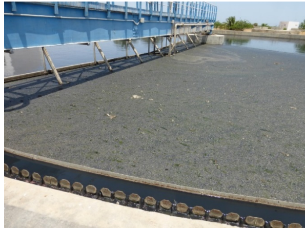
Figure 19. Vue des clarificateurs et de la présence de flottants, écumes et graisses en surface.
