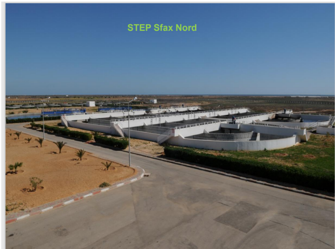
Figure 8 : Vue d'ensemble STEP Sfax Nord
