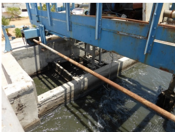
Figure 13 : Dessableurs/dégraisseurs
