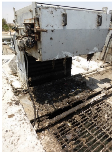
Figure 12 : Dégrilleurs et tamis rotatif (garuche)
