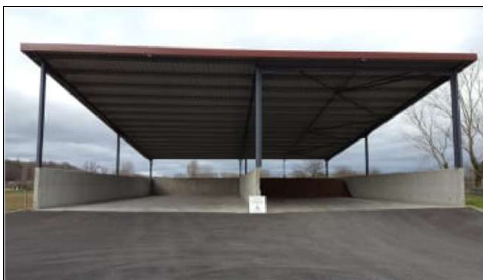
Figure 12 : Hangars de stockage de boues – Modèle type
