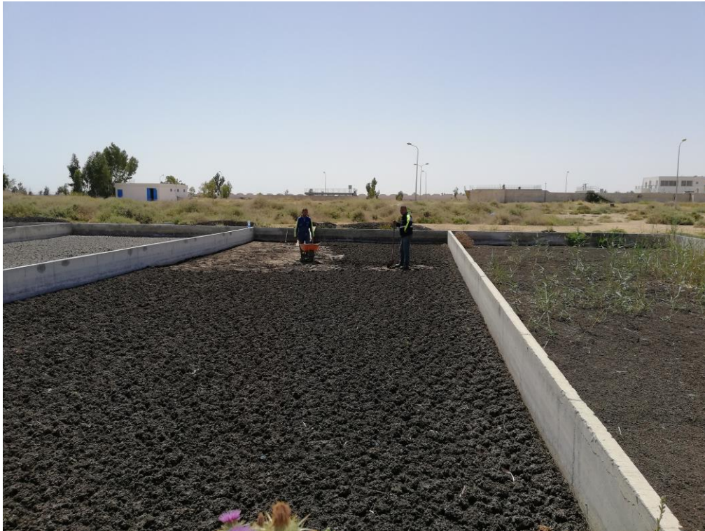
Figure 7 : Lits de séchage des boues
